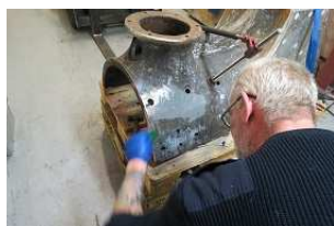
Afwerking met metaalepoxy coating
