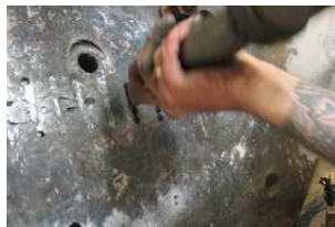
uitbeitelen van tussen stukjes. Inklinken van locks.
