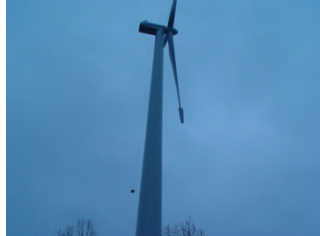
Werkzaamheden uitgevoerd in een windmolen
