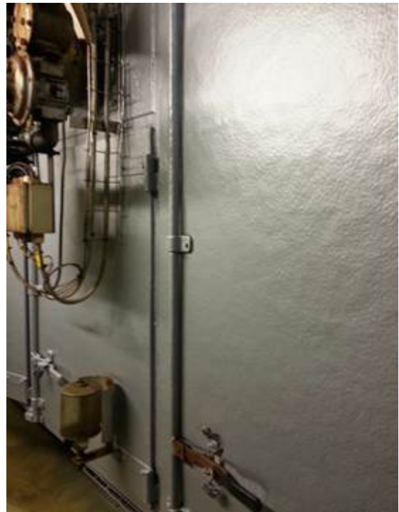
Na dat de coating is aangebracht
