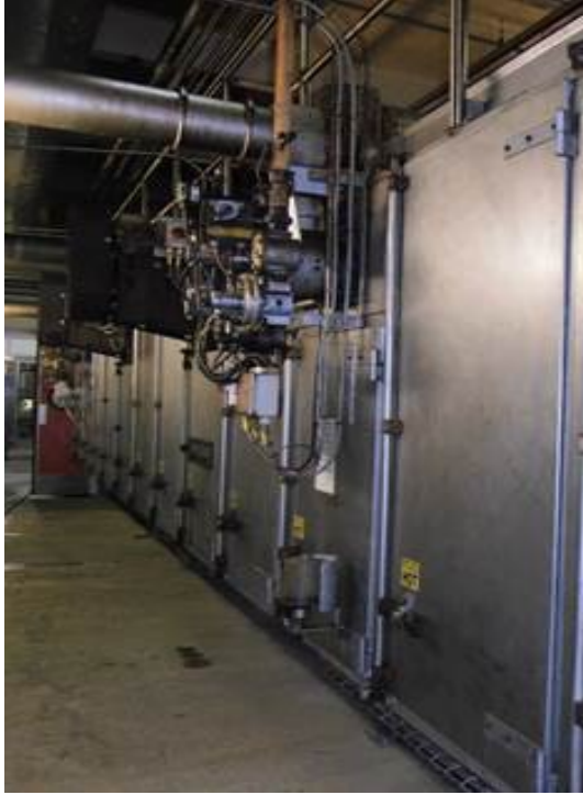
Voor de coating werd aangebracht
